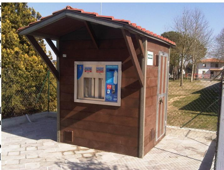
*Dimensioni: base lato porta 160 cm. Lato pannello erogazione 180 cm. Sporgenza tetto cm 70 altezza linea tetto cm 204 (le misure sono lato esterno)*
